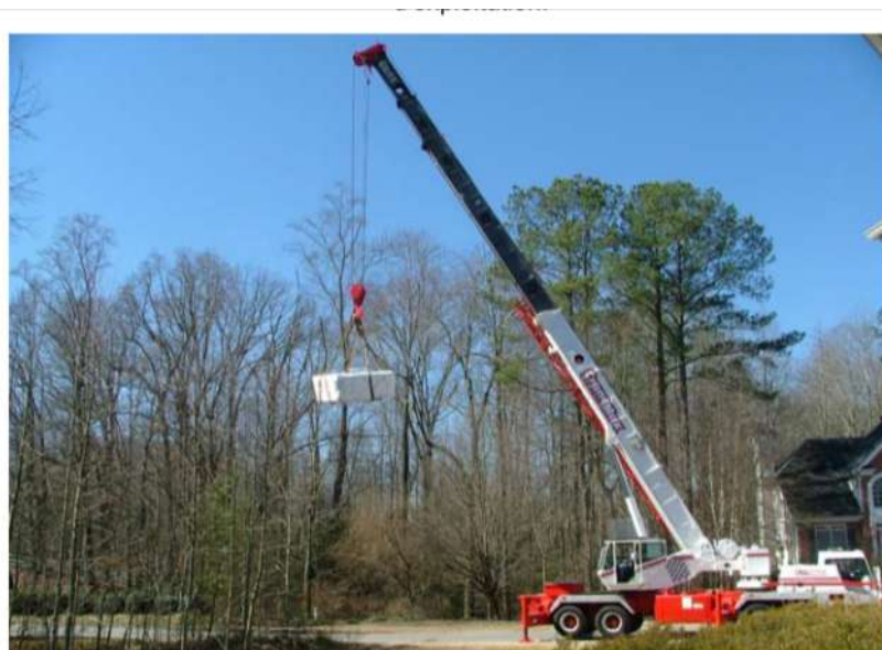
Figure 3 – Une grue est souvent nécessaire pour la livraison d'un spa de nage
